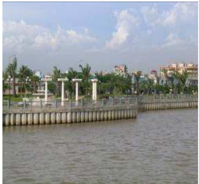
Bờ kè và Công viên ven sông Đồng Nai, TP. Biên Hòa. Công trình được thi công theo công nghệ hạ cọc ván bê tông cốt thép dự ứng lực bằng phương pháp xói rung của Nhật Bản.
